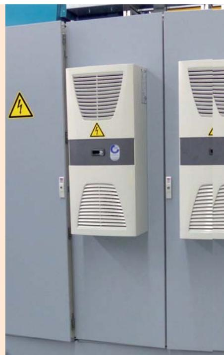
**1** TBT stattet die Schaltschränke sämtlicher Tiefbohrmaschinen mit Kühlaggregaten der neuesten Generation aus. Diese ermöglichen Energieeinsparungen bis 45 Prozent.
